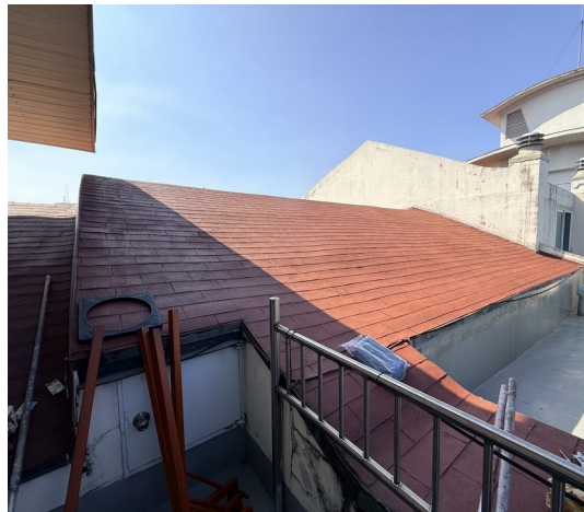
시공 전 — 퇴색·오염된 아스팔트 싱글
