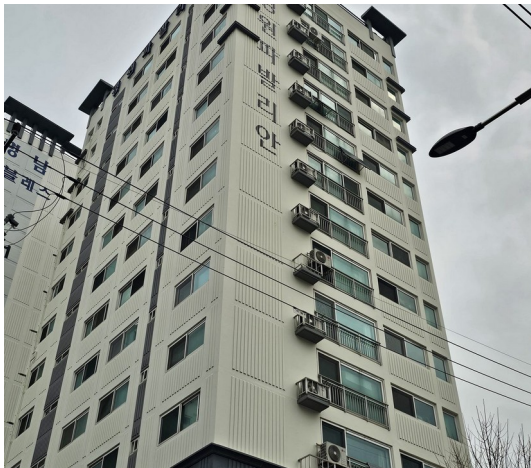
시공 전 현황 — 구간을 나눠 기록
