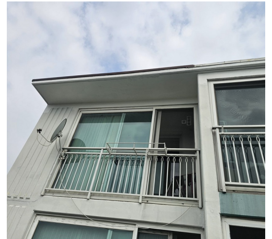
최상층 외벽 전경
